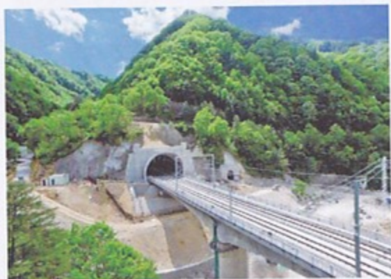
↑ 西成高铁天华山隧道——亚洲最长的单洞双线高铁隧道
