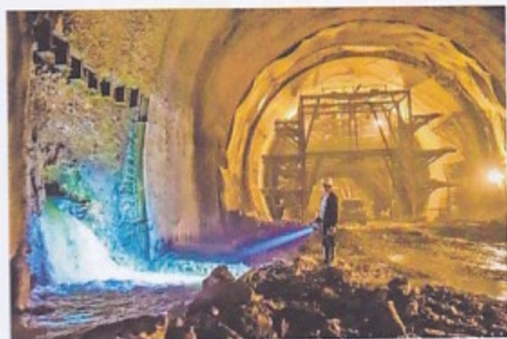
↑ 施工人员监测隧道内的涌水情况
