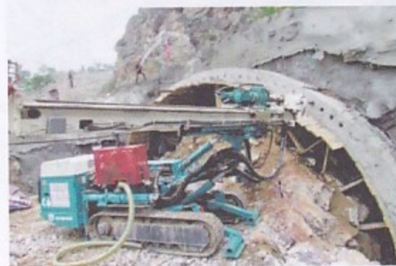
↑ C6 多功能钻机进行管棚作业
