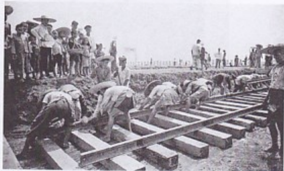
↑ 成渝铁路徒手安装铁轨
