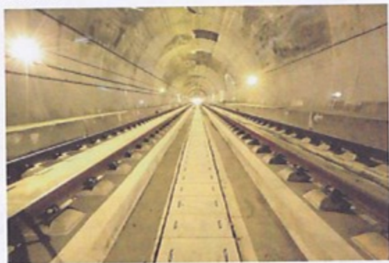
↑ 西成高铁菜子坪二号隧道内景
