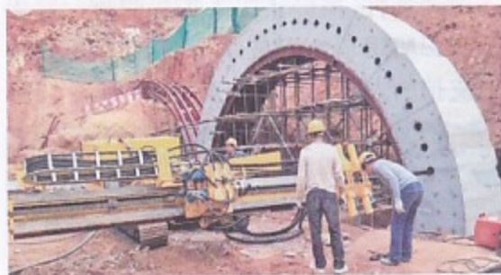
↑ 管棚钻机超前支护作业
